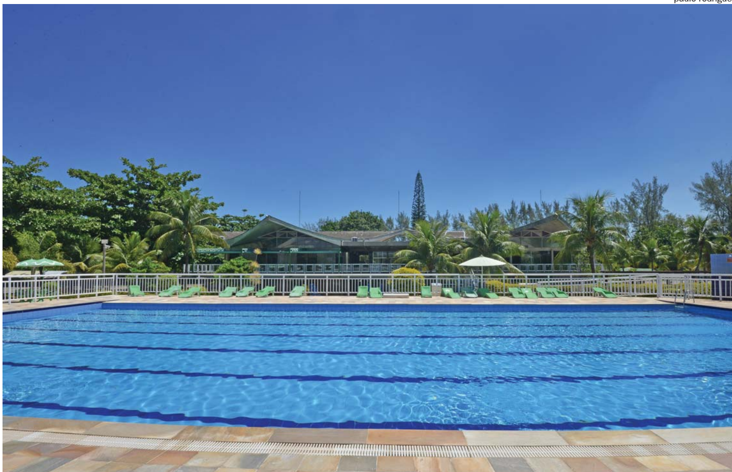
Na atual gestão patrimonial, a piscina do Clube da Barra passou por reforma para recuperar a estrutura da laje do deck
